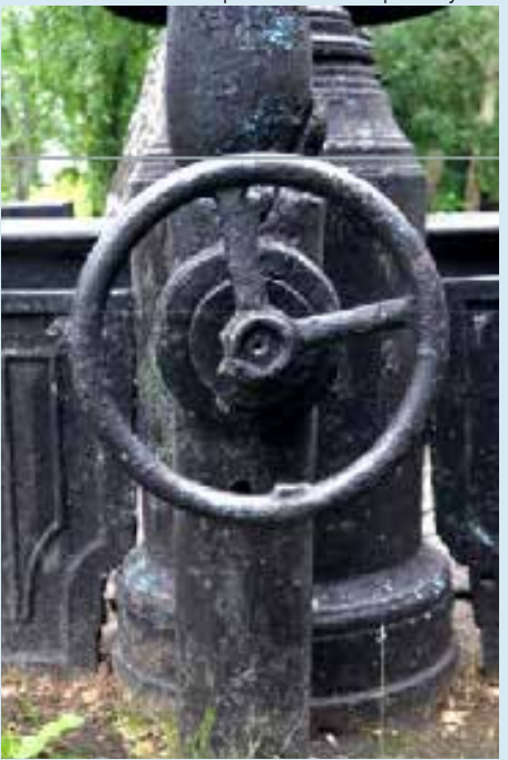
Элементы фонтана. Запорный узел
